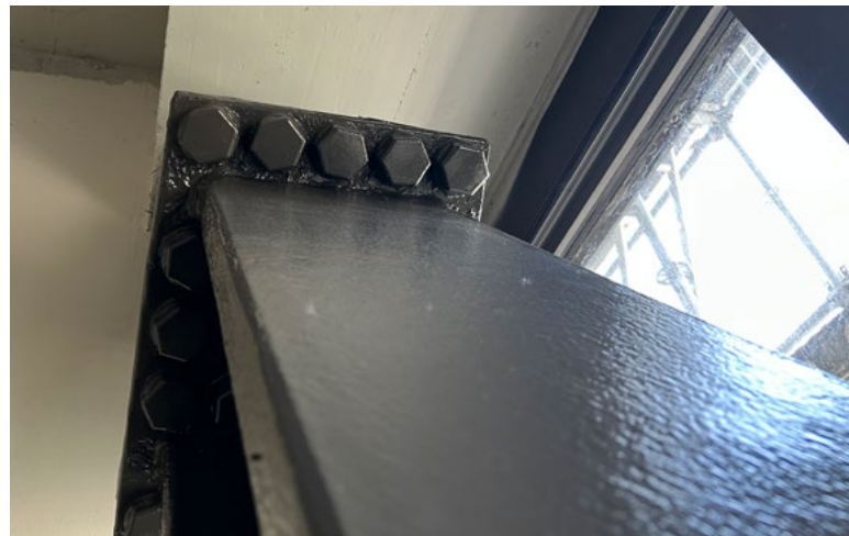
Aus Brandschutzbeschichtung gefertigte Kappen für Schrauben
